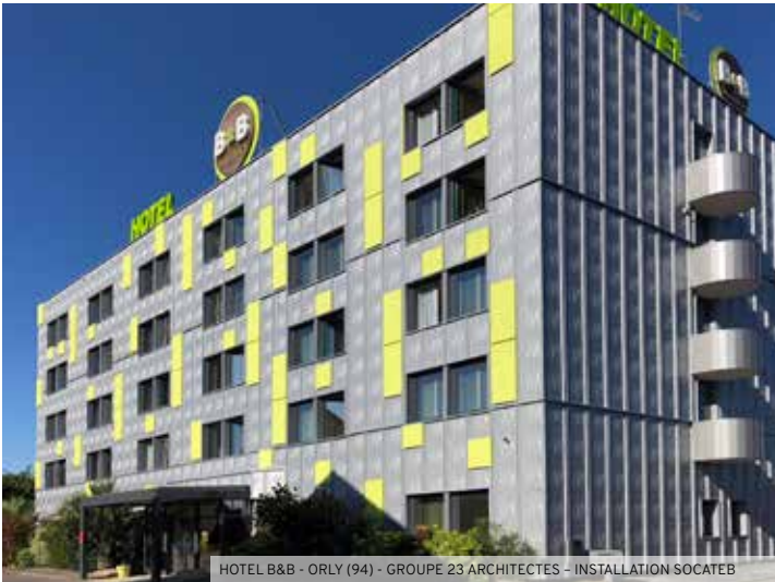
HOTEL B&B - ORLY (94) - GROUPE 23 ARCHITECTES - INSTALLATION SOCATEB
