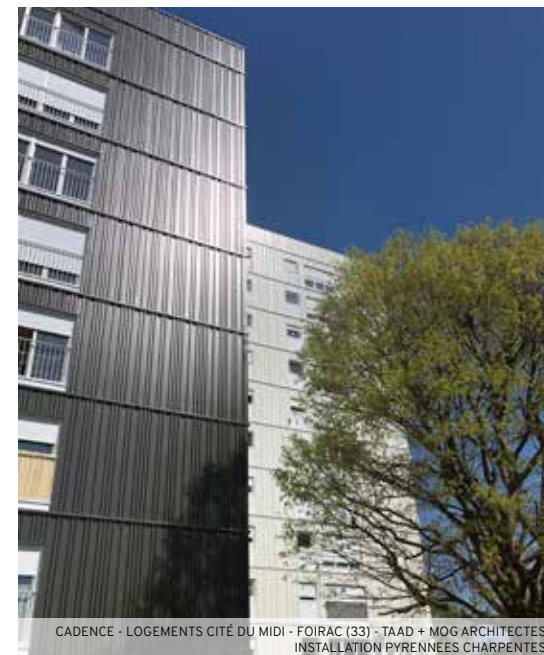
CADENCE - LOGEMENTS CITÉ DU MIDI - FOIRAC (33) - TAAD + MOG ARCHITECTES PHOTO ARTHUR PEQUIN MOG ARCHI - INSTALLATION PYRENNES CHARPENTES
